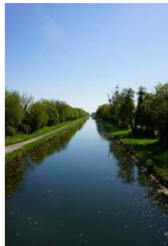
Figure 226 : Traversée du canal sud d'Orconte
